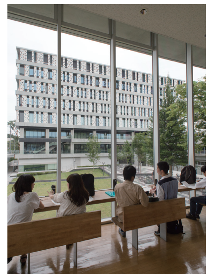
既存15号館から中庭を挟み、新しい2号館をみる
